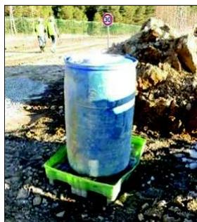
Figure 40 : Stockage d'hydrocarbures dans un bidon étanche sur bac de rétention (Source : Abies, suivi de chantier)
