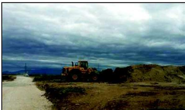
Figure 44 : Reprise de la terre stockée pour le remblayage des fondations (Source : Abies, suivi de chantier éolien)
