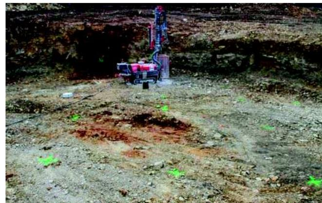
Figure 39 : Foreuse géotechnique sur un chantier éolien (Source : Abies)
